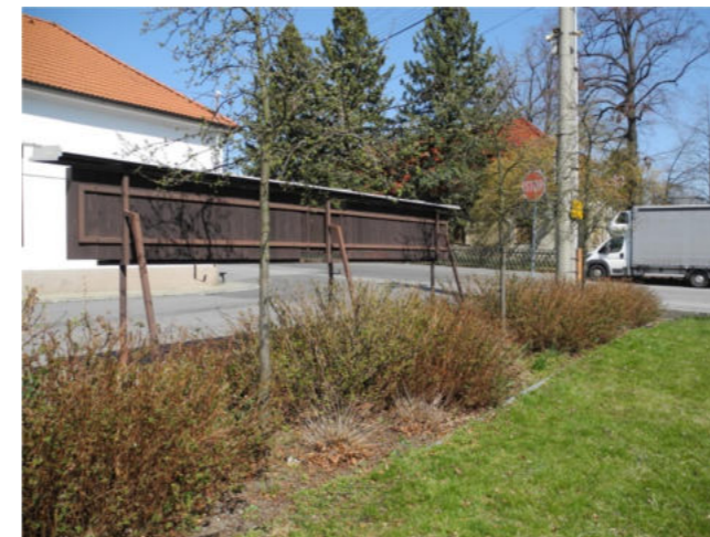
Detail keřového záhonu a vývsních skříňů
